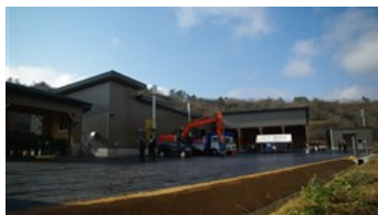
中津川にあるバイオマス製造施設
