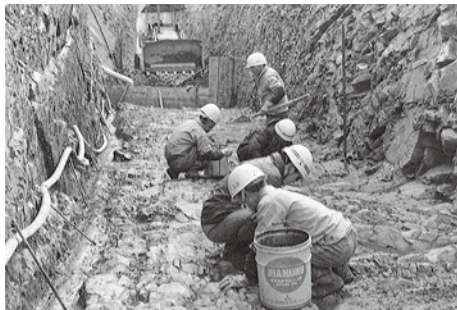
監査廊の岩盤洗浄の様子
