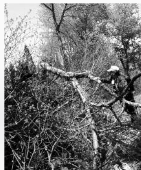
倒木の撤去作業
