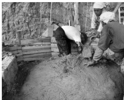
窯本体の製作最終工程。窯天井部分の壁塗り作業
