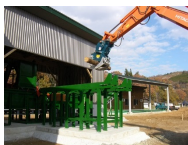
木質バイオマス製造施設
