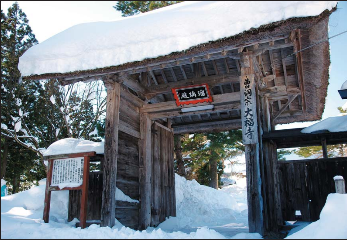
写真/雪の重みにも耐える堅牢な山門。冬場の立地条件を考慮し、しっかりした木材を使い、巧みな建築技術が施されている
