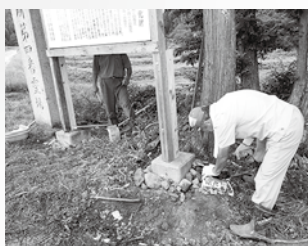
文化財看板の修理
