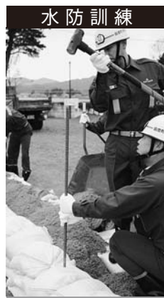
河川の水位上昇に対応する積み土の工法
