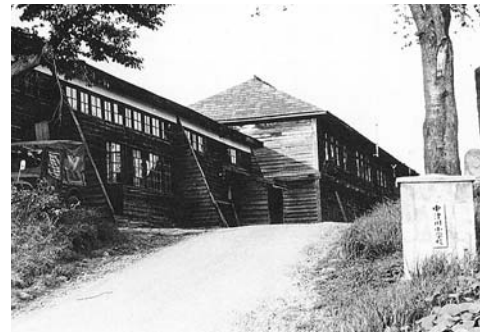
昭和22年中津川村立中津川中学校開設 (中津川村立中津川小学校に併設)
